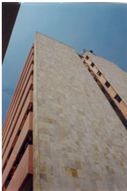
Figura 4.7 - Vista general de la torre del Hospital San Alejandro
