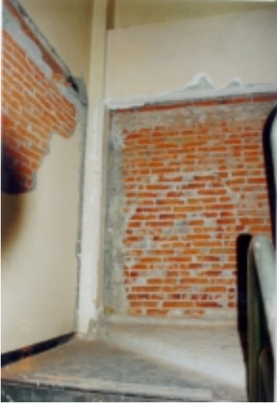
Figuras 4.16 y 4.17 - Daño no estructural en cubo de escaleras y zona de quirófanos
