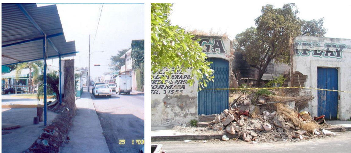
Figura 7.122 Colapso de bardas de adobe
