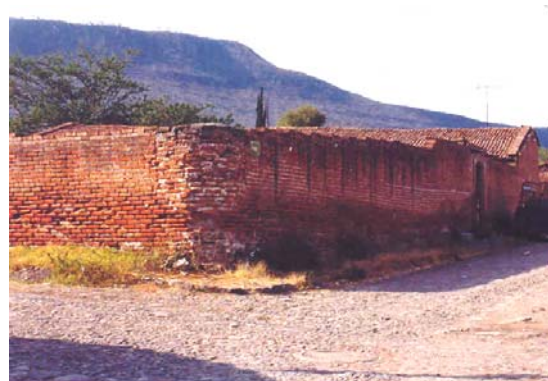
Figura 7.76 Tendencia a construir bardas de gran longitud de mampostería simple (sin refuerzo de elementos para resistir momento fuera del plano)
