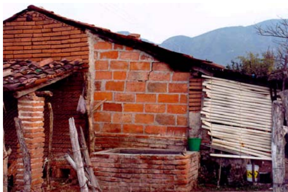
Figura 7.98 Mampostería simple de piezas diferentes
