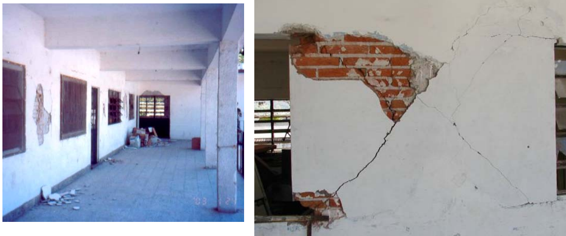
Figura 11.15 Agrietamiento en X en segmentos de muro en la planta alta
