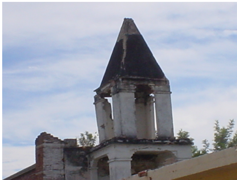
Figura 10.25 Daños severos en los extremos de las columnas de la estructura de campanario
