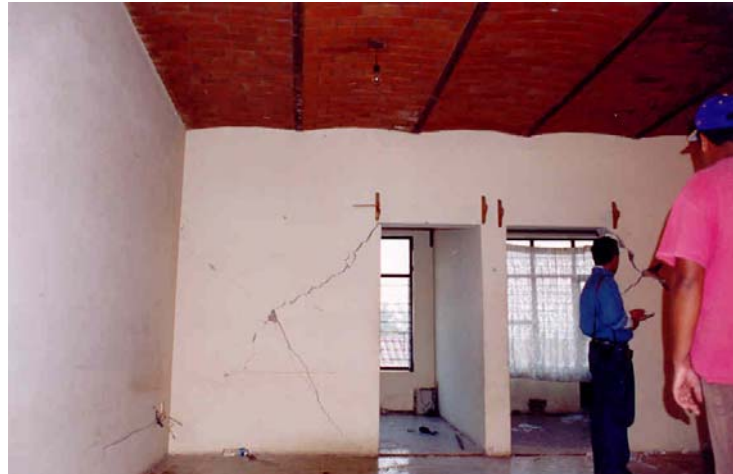
Figura 7.74 Agrietamiento en mampostería confinada con elementos de concreto reforzado de segundos niveles sobre un primer nivel con muros de adobe sin refuerzo
