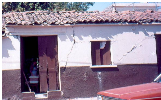
Figura 7.7 Agrietamiento inclinado
