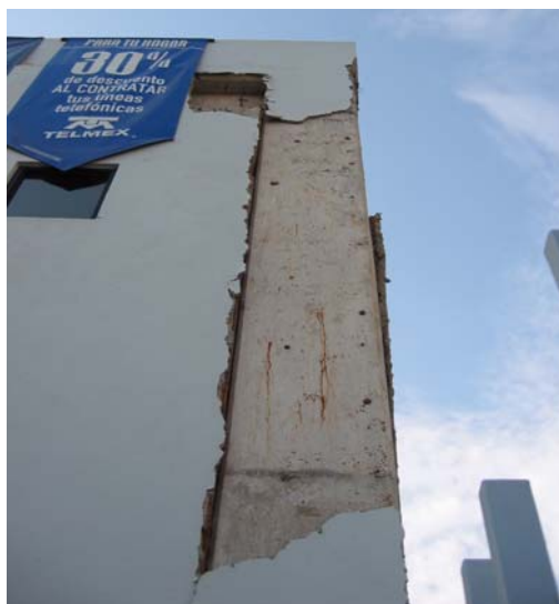
Figura 12.4 Caída del aplanado en un elemento estructural por defectos constructivos
