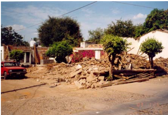
Figura 7.34 Daño total en edificaciones de adobe por ausencia de liga entre los muros
