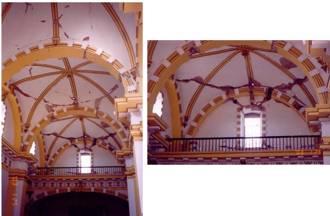
Figura 10.11 Daño observado en las cúpulas de la iglesia
