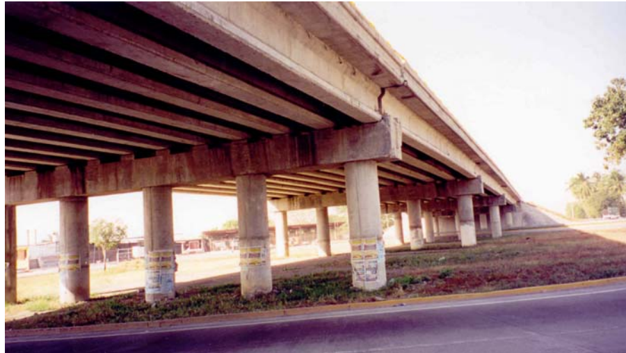
Figura 6.5 Vista general del puente “Manzanillo”
