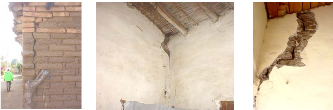
Figura 7.67 Agrietamiento vertical en esquinas de muros de mampostería por ausencia de elementos que los ligen a muros transversales
