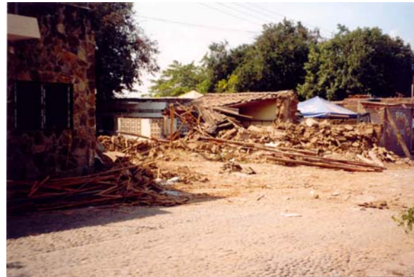
Figura 7.34 Daño total en edificaciones de adobe por ausencia de liga entre los muros
