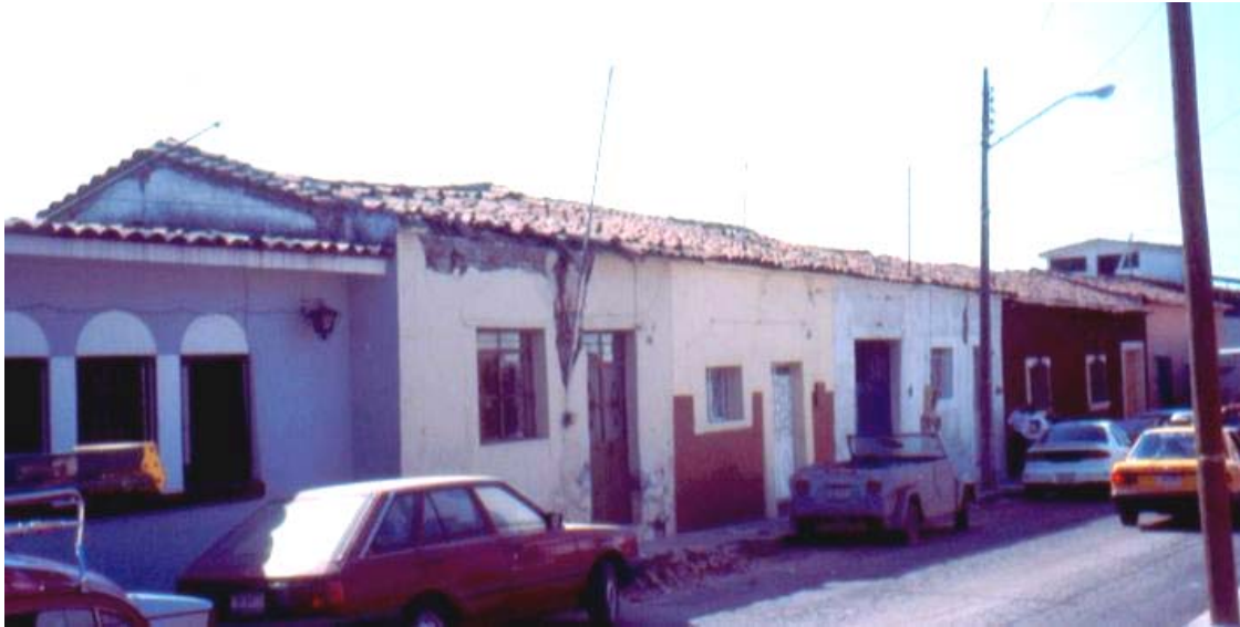
Figura 7.2 Geometría de vivienda de adobe: varias casas alineadas con techo a dos aguas con teja
