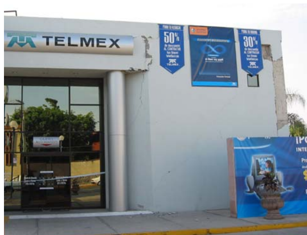
Figura 12.3 Fachada frontal del edificio
