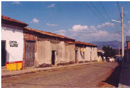
Figura 7.75 Las viviendas están resueltas principalmente con adobe y mampostería simple (no reforzada) con recubrimiento de mortero (enjarre)
