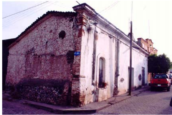
Figura 7.86 Agrietamiento en construcciones relativamente antiguas con muros de adobe, tabique de barro y piedra sin refuerzo
