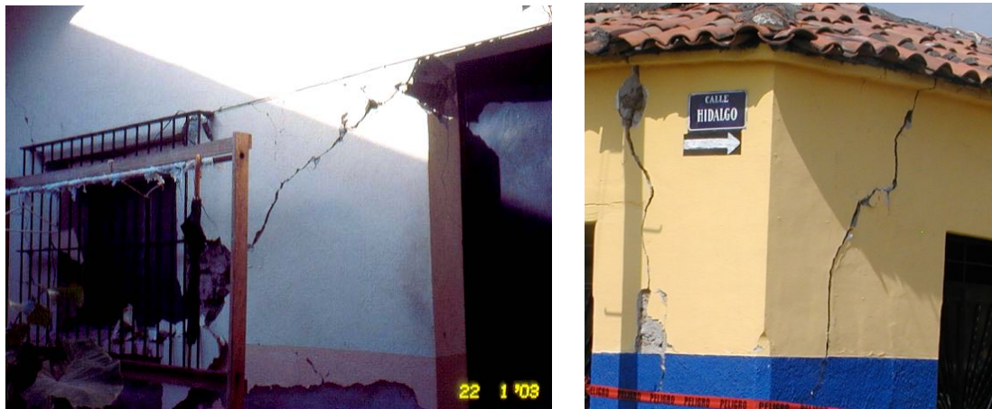
Figura 7.6 Agrietamiento inclinado
