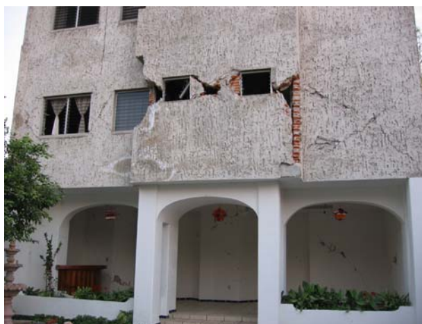
Figura 7. 27 Fachada posterior del edificio
