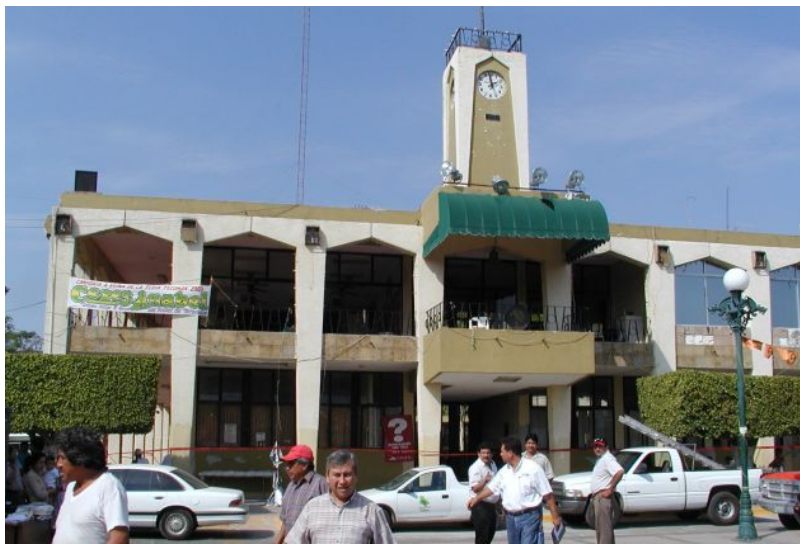
Figura 11.19 Fachada de la Presidencia Municipal, Tecomán, Col.
