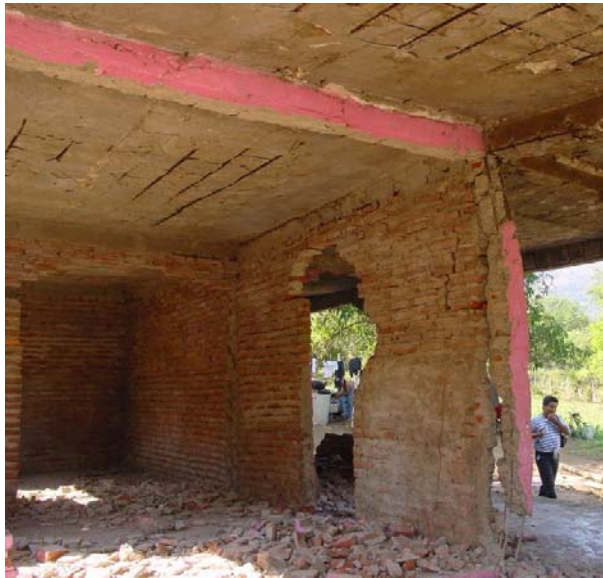
Figura 7.119 Daño severo en viviendas construidas con materiales de mala calidad y el acero de refuerzo expuesto
