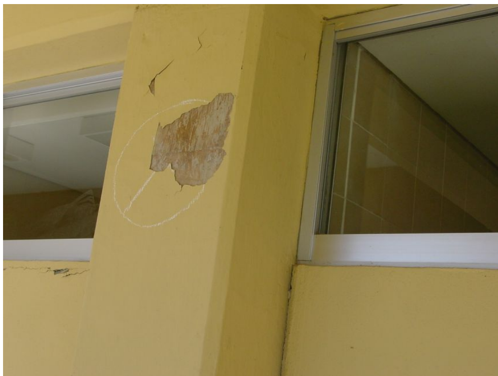
Figura 9.18 Daño ligero en una columna del Hospital del IMSS en Coahuila de Zaragoza
