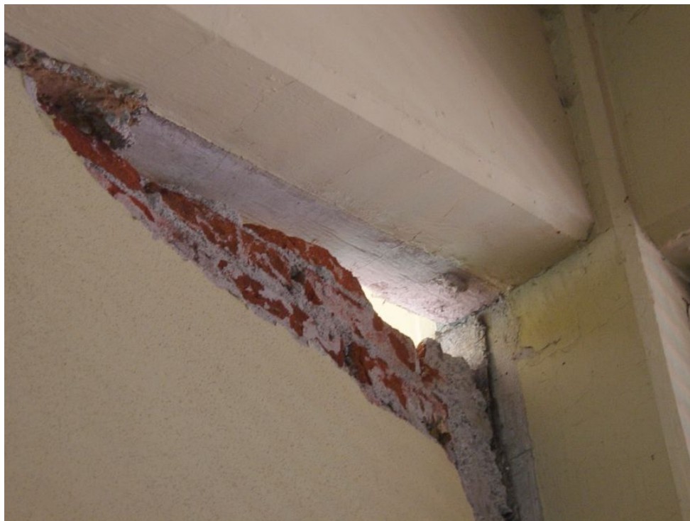
Figura 9.17 Daño en muro divisorio del Hospital del IMSS en Coahuila de Zaragoza
