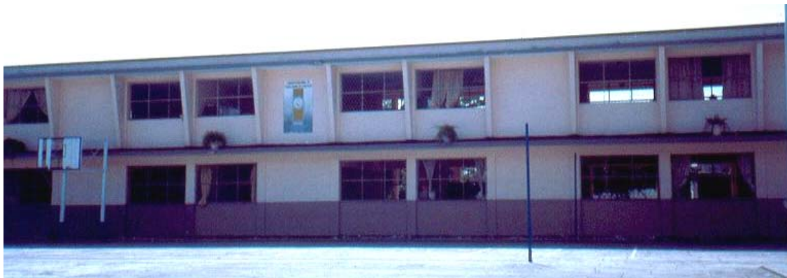
Figura 8.3 Fachada de uno de los edificios
