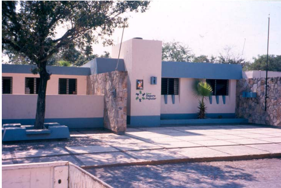
Figura 9.16 Edificio del Sector Salud (Seguro Popular)
