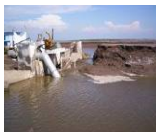
Daños en bordos y equipo de bombeo de las unidades acuícolas
