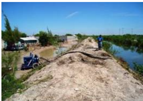
Figura 2.173 Bordo perimetral del dren El Anhelito
