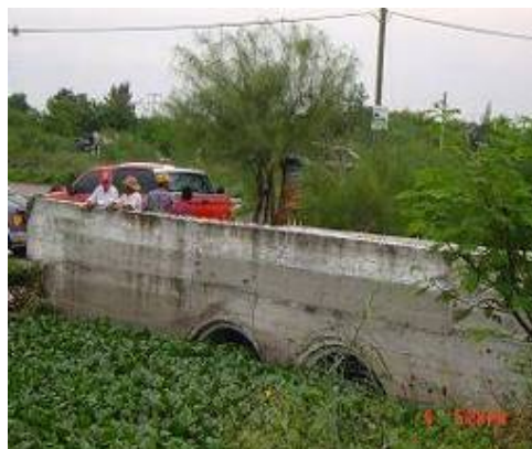
Figura 2.198 Dren Río Bravo, municipio Río Bravo donde se observó obstrucción por lirio acuático
