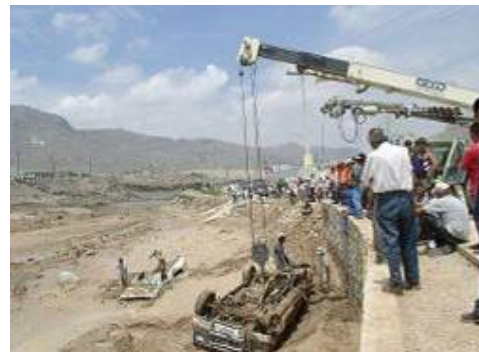
Figura 2.45 Afectaciones en el dique Los Ojitos
