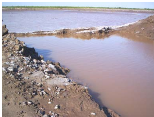
B. Ruptura de bordos
