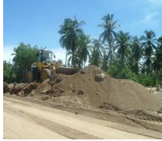
Figura 2.153 Labores de desazolve
