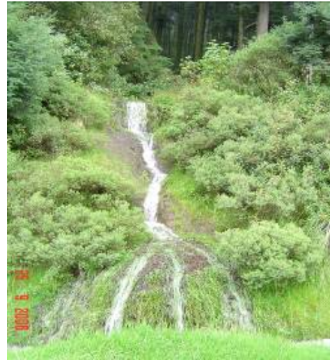
Figura 5.7 Debido a que las contracunetas se encontraban obstruidas, el agua de lluvia escurría por el terreno natural, y no por los lavaderos que se construyen para ello
