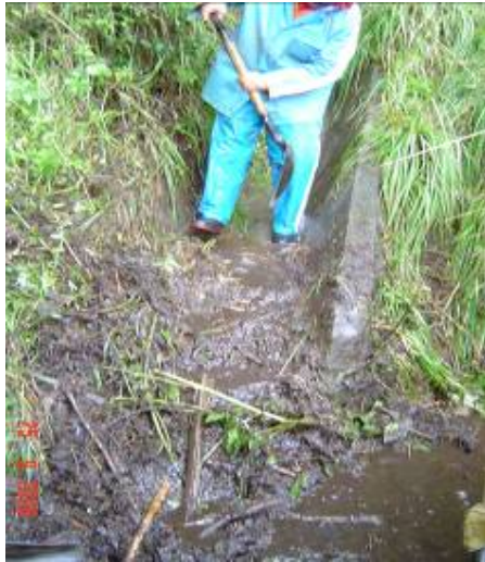
Figura 5.6 Limpieza de los drenes obstruidos arriba de la escarpa de falla del deslizamiento en el km. 32.5
