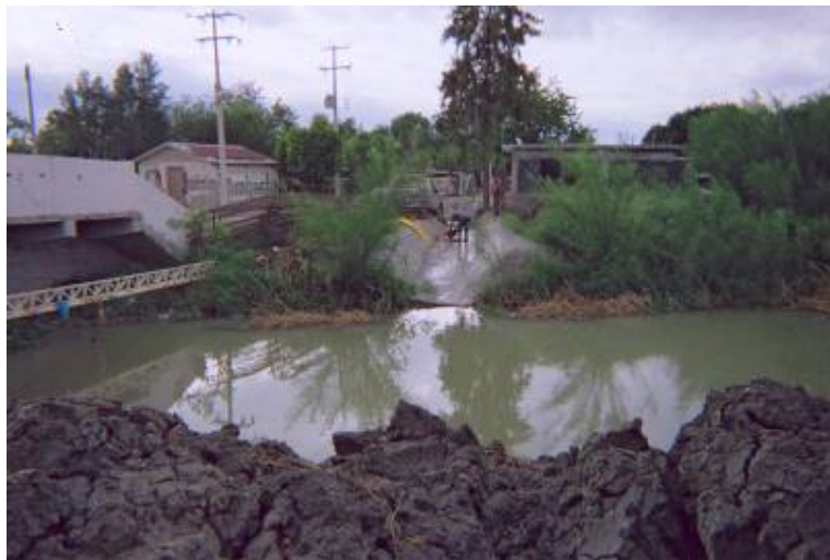
Figura 2.185 Estructura para desaguar la zona de inundación hacia el dren Río Bravo
