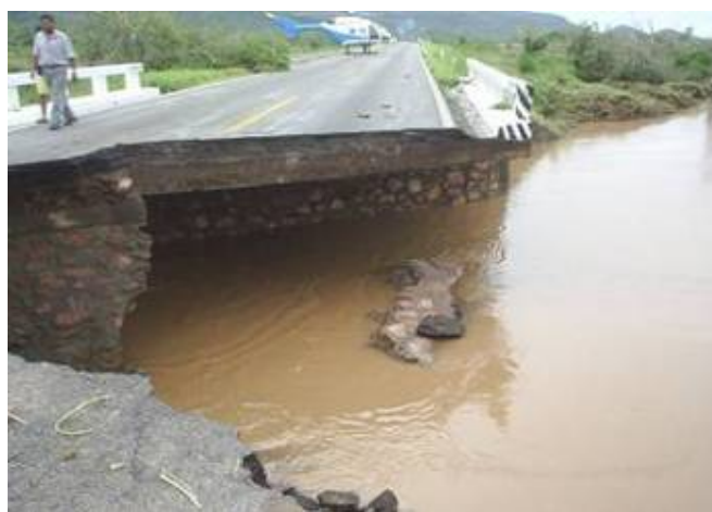
Figura 2.138 Daño en el puente “Las Flores” de la carretera federal Mazatlán-Culiacán, como consecuencia del huracán Lane
