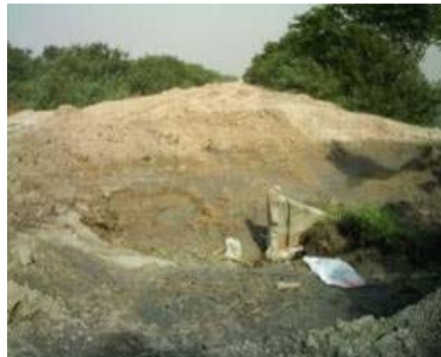
Figura 2.202 Pérdida de material en terraplén de acceso de obra de drenaje que ocasionó incomunicación a una comunidad en el municipio de Río Bravo. Foto tomada días después de las lluvias
