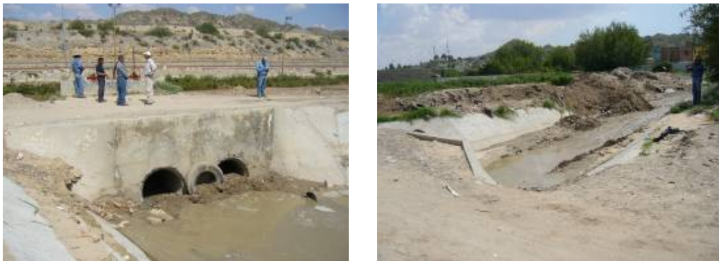
Figura 2.33 Una de las compuertas para descargar los escurrimientos que bajan de la sierra
