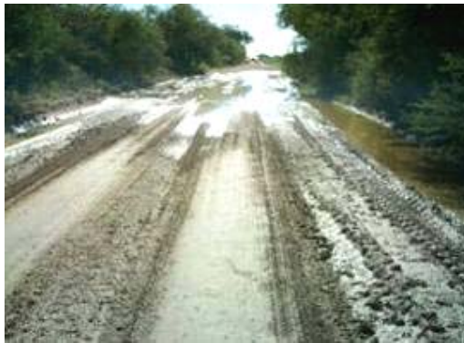
Figura 2.202 Pérdida de material en terraplén de acceso de obra de drenaje que ocasionó incomunicación a una comunidad en el municipio de Río Bravo. Foto tomada días después de las lluvias
