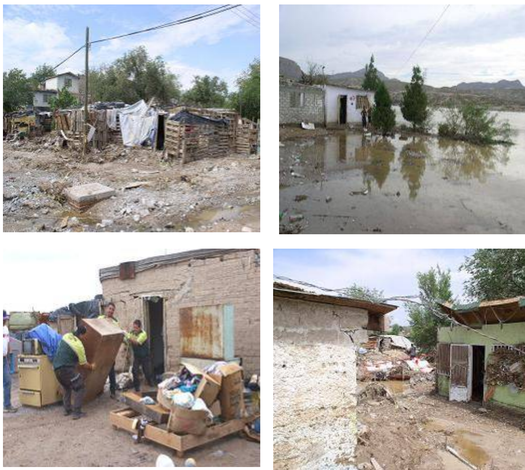
Figura 2.42 Viviendas con diversas afectaciones
