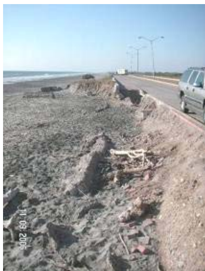
A. Erosión de la playa
