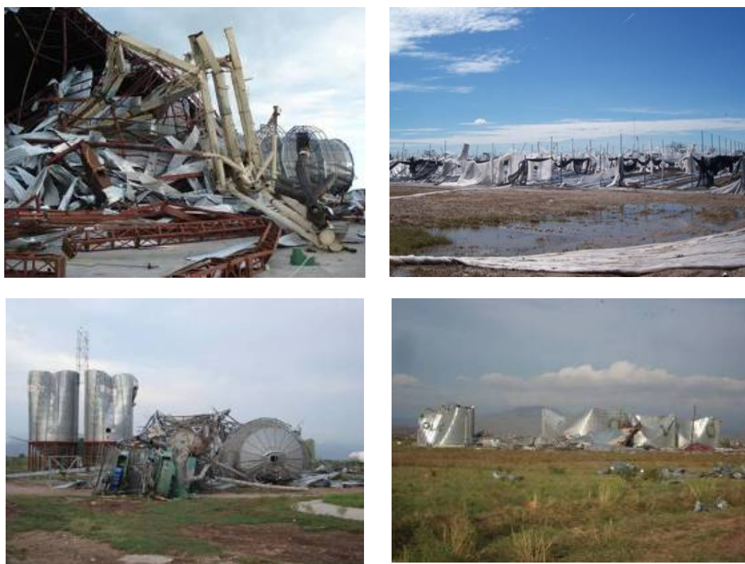
Figura 2.141 Daños en infraestructura agrícola
