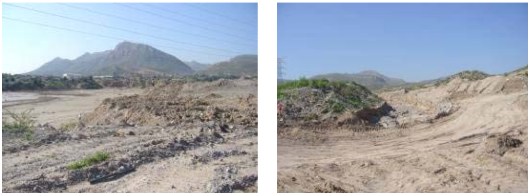
Figura 2.21 Tajo abierto alrededor al dique La Fronteriza. Vista desde la margen izquierda y en su recorrido
