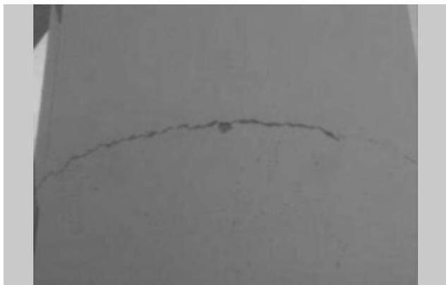
Figura 3.27 Agrietamientos en columnas
