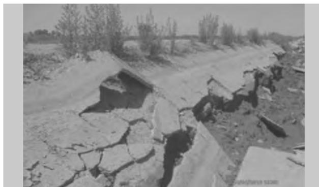
**Figura 3.26 Severos daños en los canales de riego**
