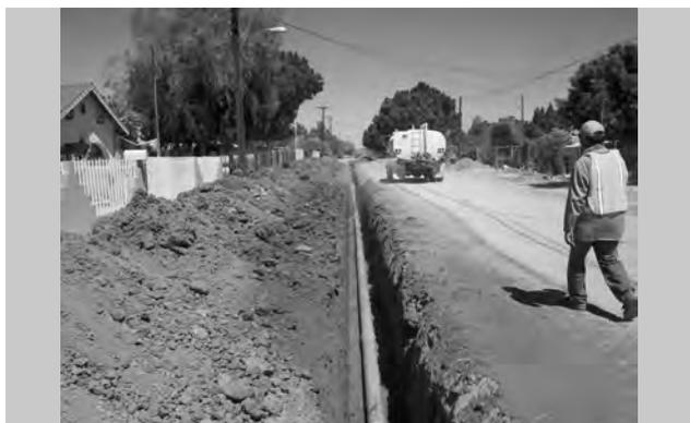
Figura 3.21 Acciones de reconstrucción de infraestructura de agua potable
