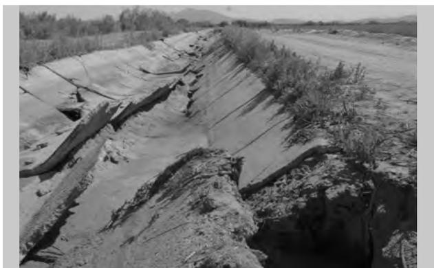
Figura a) Daño en canales de riego.
