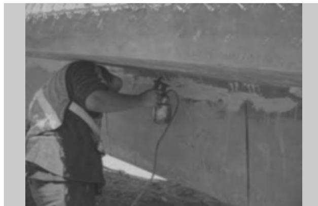
Figura 3.28 Sellado de grietas con resina epóxica
