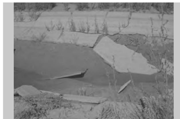
**Figura 3.24 Daños en infraestructura hidroagrícola en la zona del Valle de Mexicali**
