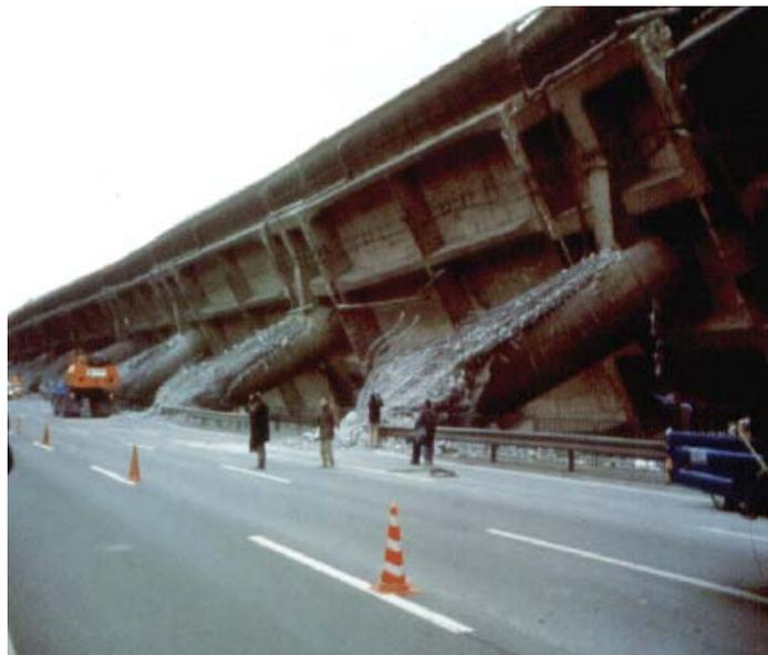
**Figura 4 Daños observados en la subestructura o infraestructura (tomadas de Riobóo, 2005)**
