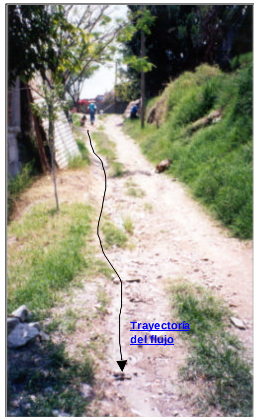
Figura 2.63 Desalojo de aguas residuales sobre la calle
