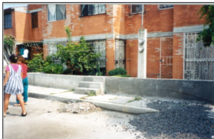
Figura 2.71 Pequeños muros en la entrada de las casas para protegerse de las inundaciones
