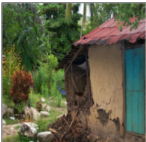
Figura 3.2 Daños en vivienda construida de varas y lodo
