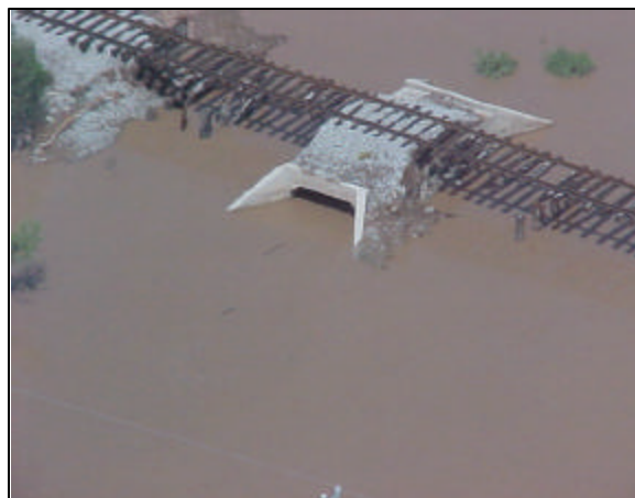
Figura 2.21 Vista aérea de los daños en la infraestructura de transporte
