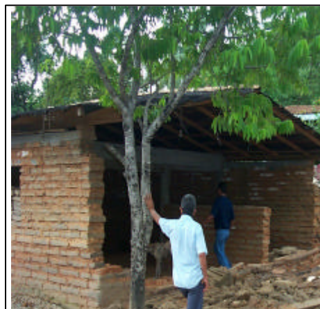
Figura 3.2 Daños en vivienda construida de varas y lodo
