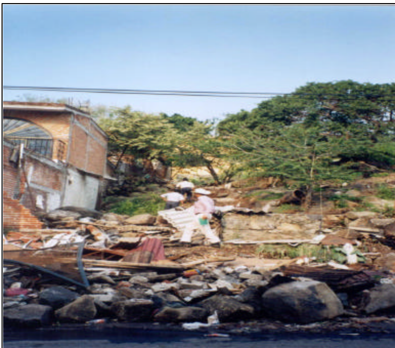
Figura 2.73 Casa endeble derribada por una corriente del agua
