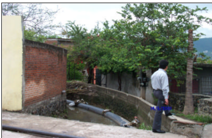
Figura 2.59 Casa invadiendo el cauce del río en la colonia Progreso, municipio de Jiutepec
