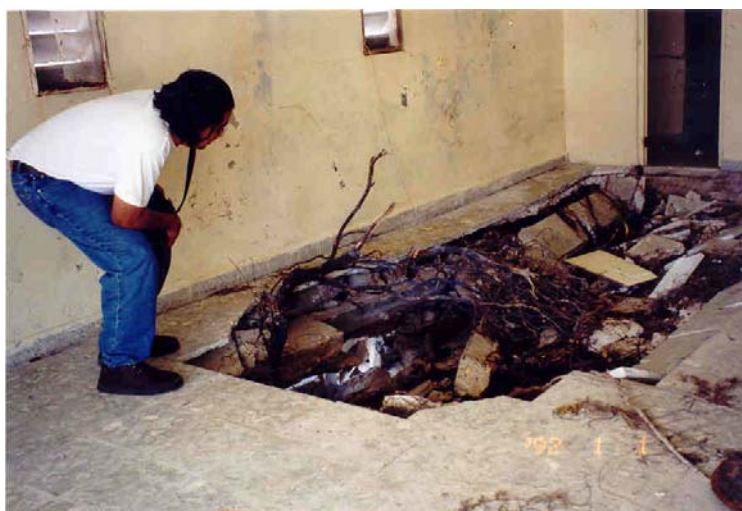
Figura 2.71 Socavación de cimientos en una vivienda en Telchac Puerto
