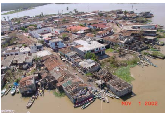
Figura 2.116 Desprendimiento de techos en viviendas
