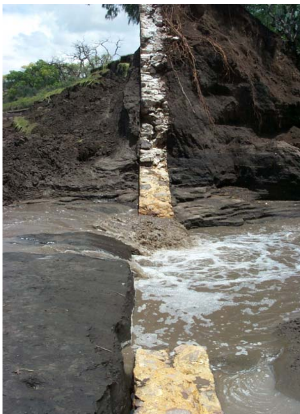
Figura 2.37 Debido a la acumulación de azolves las obras de toma se encontraban fuera de servicio
