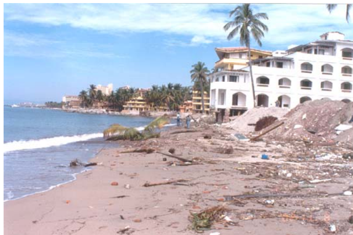
Figura 2.95 Playa erosionada sin depósitos de grava
