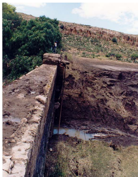
Figura 2.37 Debido a la acumulación de azolves las obras de toma se encontraban fuera de servicio
