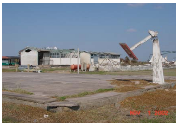
Figura 2.118 Daños observados en edificios escolares
