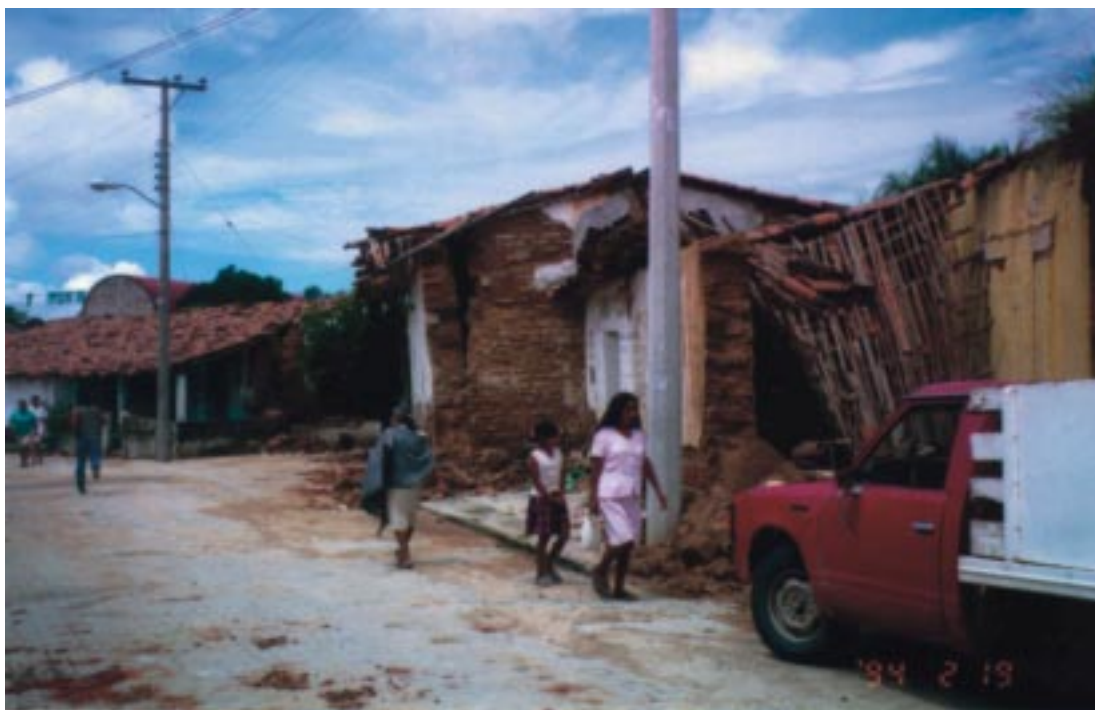
Figura 27. Daños típicos en construcciones de adobe
