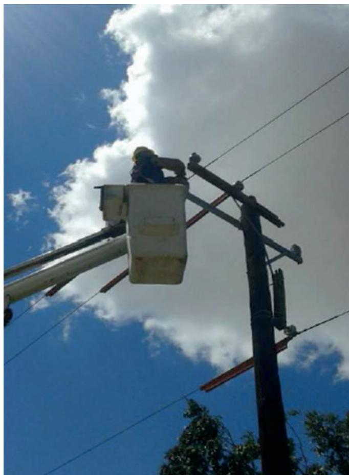
**Figura 2.22 Trabajos de restablecimiento en circuitos de media tensión (13.8 kV)**
