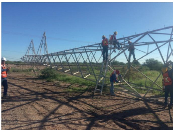
**Figura 2.21 Trabajos de restablecimiento en la línea de alta tensión subestaciones Empalme-73450-y Bâcum**
