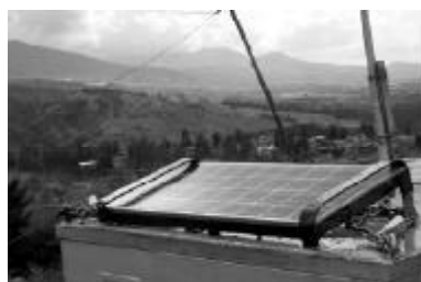
Reemplazo de paneles solares, estación Chilpancingo
