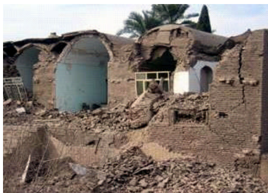
Daños severos en escuelas y construcciones con muros y techos de adobe. Bam, Irán.
