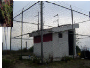
Estación repetidora Calo
