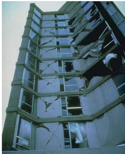
**Figura 3.96 Daños en elementos exteriores**
