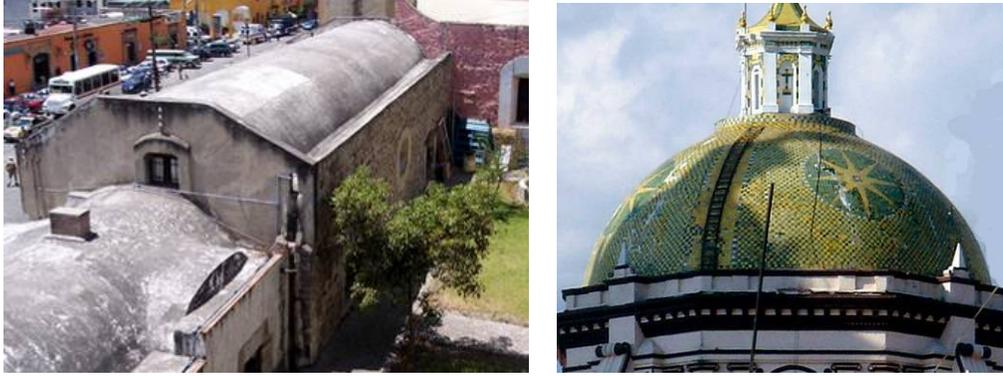
**Figura 3.59** Formas de techo abovedado a) bóveda cilíndrica; b) cúpula
