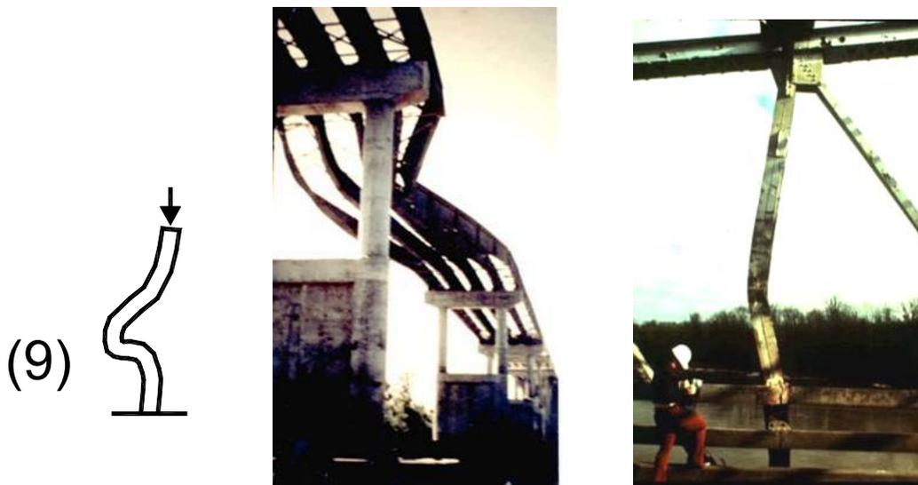
**Figura 3.85 Pandeo global:** a) esquemático b) pandeo lateral de traveses; c) pandeo de un montante de armadura
