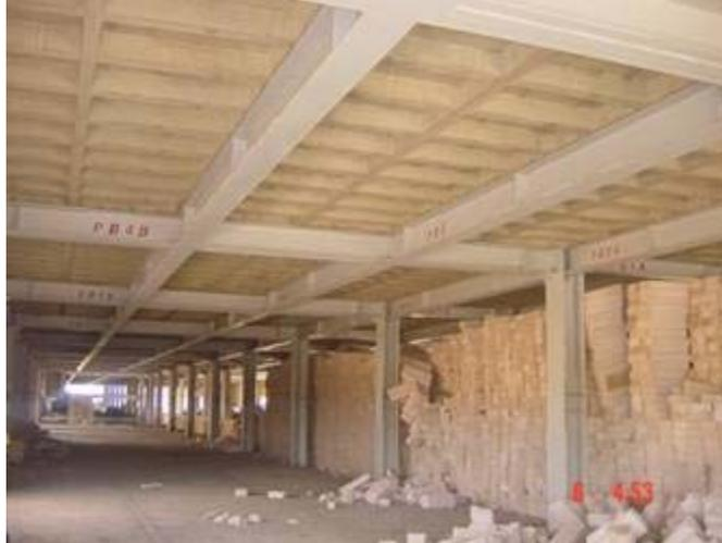
**Figura 3.47** Losa apoyada en traves
