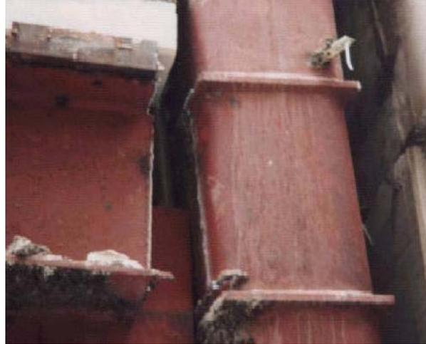
**Figura 3.86** *Falla de soldadura*
