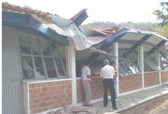
**Figura 3.89** Colapso de techo
