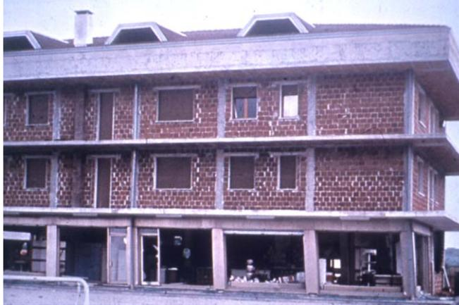
**Figura 3.26** *Planta baja flexible*
