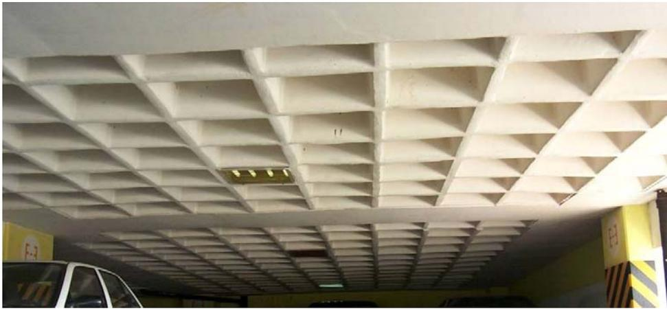
**Figura 3.53** *Losa aligerada (reticular)*
