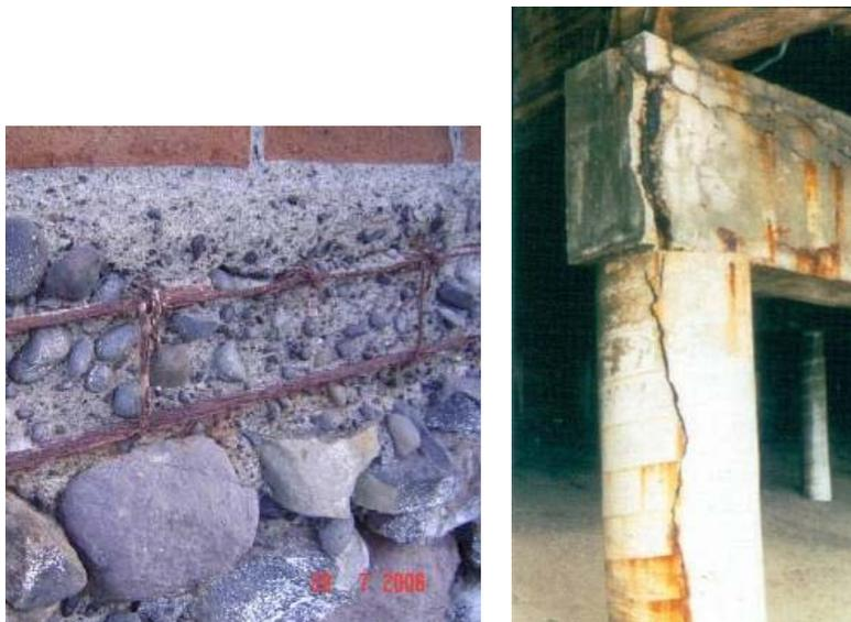
**Figura 3.88** Corrosión del acero y deterioro de materiales
