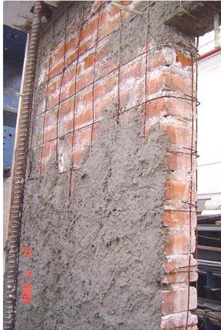
**Figura 3.63 Refuerzo en muro con malla y mortero**
