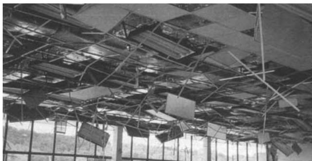
**Figura 3.98** *Daño en cielos rasos*
