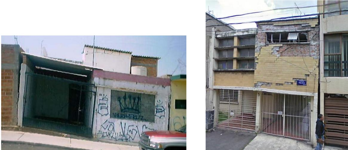
**Figura 3.68** Hundimientos diferenciales
