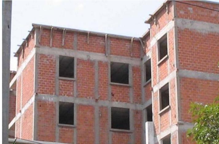
**Figura 3.42 Muros de carga de mampostería**
