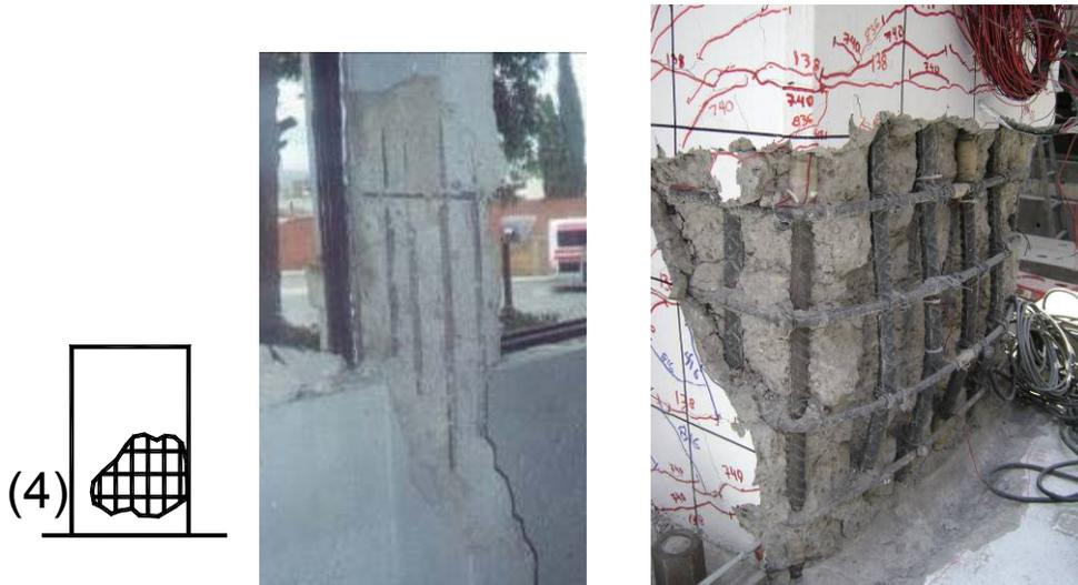
**Figura 3.80 Desprendimiento del concreto y acero de refuerzo expuesto**
