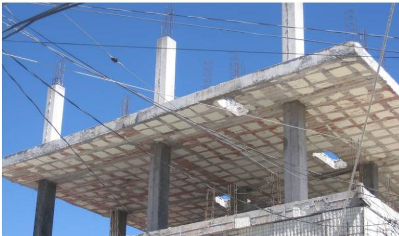
**Figura 3.48** Losa plana. Nótese las nervaduras principales y la falta de “capitel”
