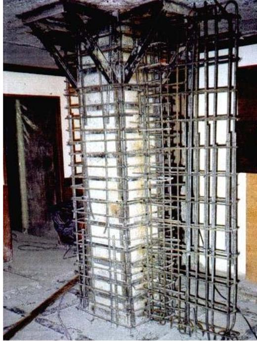
**Figura 3.61 Encamisado de concreto**
