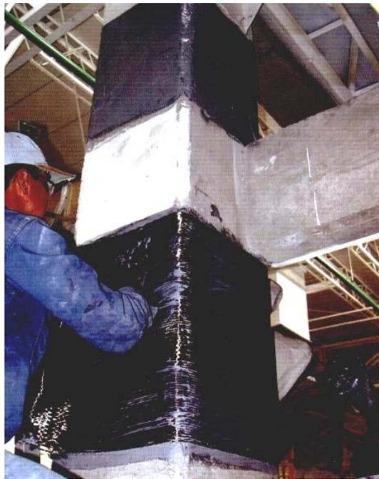
*Figura 3.65 Rehabilitación con fibras de carbono*
