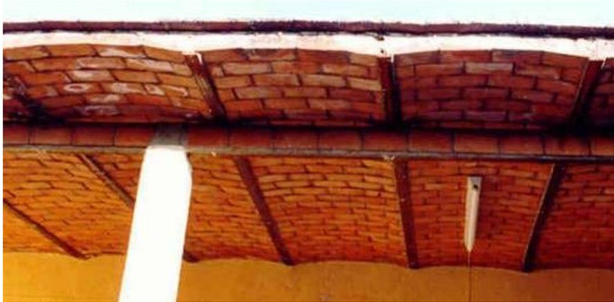
**Figura 3.50 Bóveda catalana (vigas y enladrillado)**
