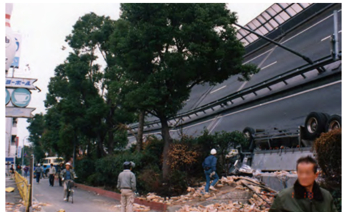
Imagen 2. autopista colapsada Fuente: cortesía de la ciudad de Kobe.
