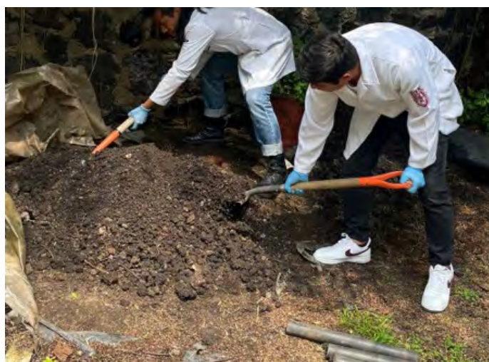
Imagen 2. Preparación de biopila a pequeña escala para tratamiento de suelo. Fuente: Cenapred
