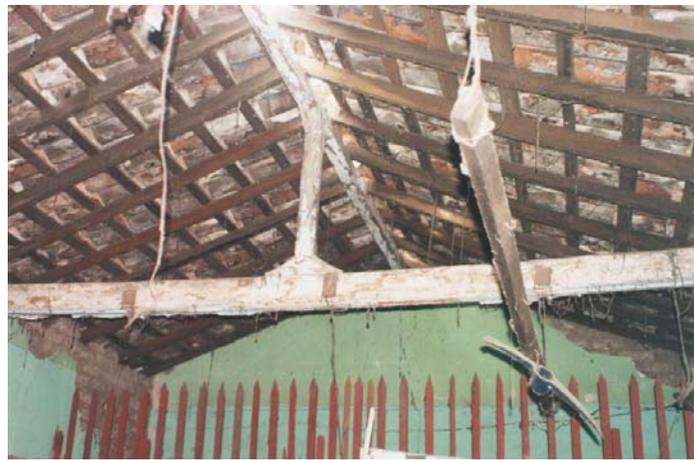
**Figura 4.4 Sistema de techo típico**
