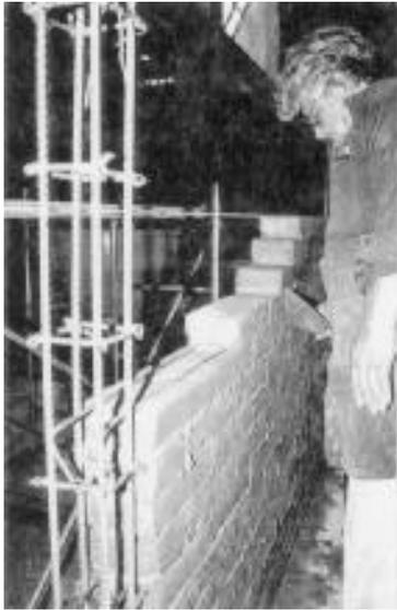
a) Colocación del tabique y detalle del anclaje del refuerzo horizontal de M4
