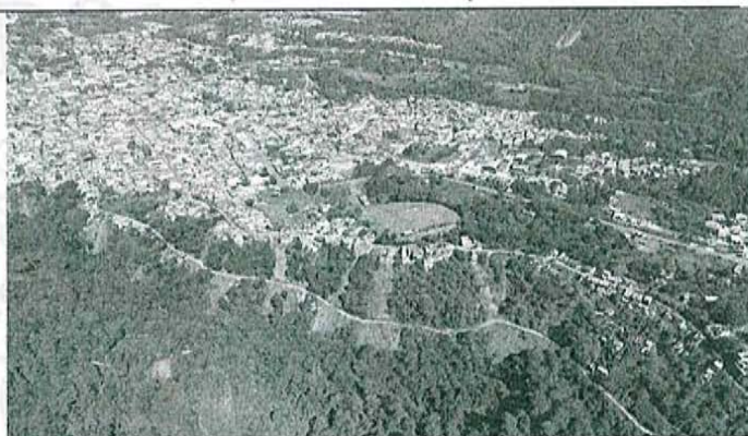
Fig. 1.2 Deslizamientos en la Ciudad de Huauchinango, Pue.
