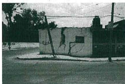
Figura 2. Afectación paulatina y persistente de la deformación a casas habitación e infraestructura urbana en la delegación Iztapalapa de la Ciudad de México.
