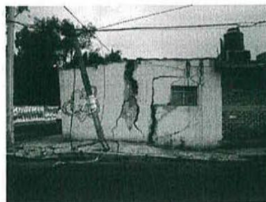
Figura 2. Afectación paulatina y persistente de la deformación a casas habitación e infraestructura urbana en la delegación Iztapalapa de la Ciudad de México.
